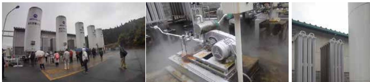
図3 CEタンク、送り出しポンプと蒸発器。
