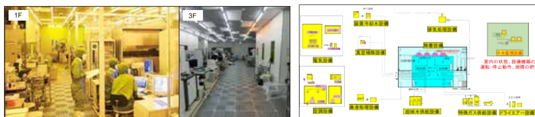
図 ナノ・スピン実験施設クリーンルーム内観 (左) クリーンルームを構成する設備 (右)
