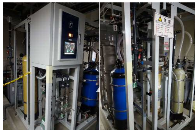
純水製造装置
